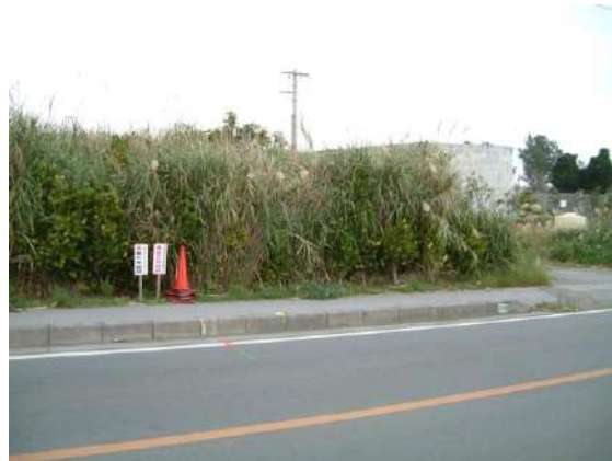
④女子第3中継所（今泊増圧ポンプ場）
